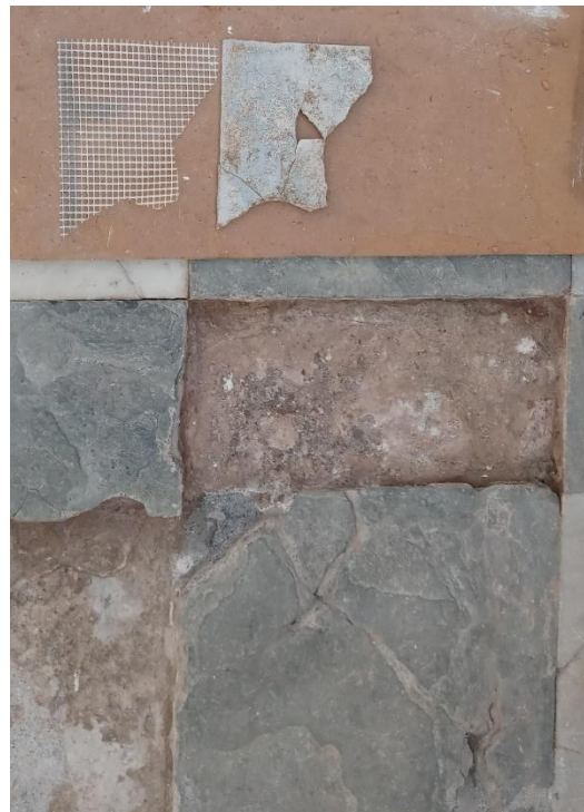
Opus sectile in ardesia e marmo bardiglio Consolidamento esfoliazione, incollaggio lastre fratturate e riallettamento
