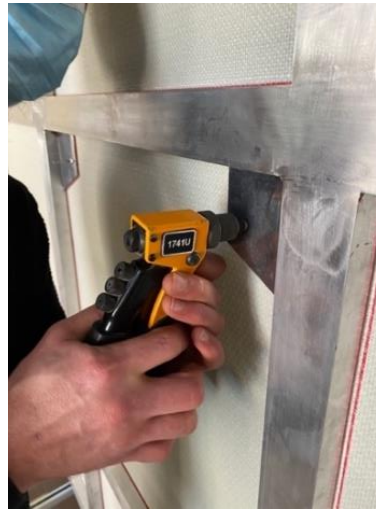
Preparazione dei nuovi supporti
